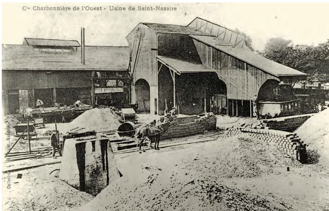
Usine de la C ie Charbonnière de l'Ouest située entre le bd Leferme et le quai des Grands Puits. Les bureaux de la compagnie se situent au 18, rue Thiers Archives municipales de Saint-Nazaire, cliché 1234 tiré d'un négatif.
