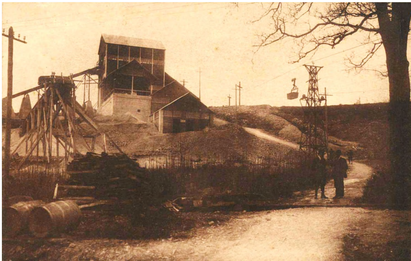
La carrière produit des sables, pierres, gravillons et macadam pour les travaux routiers et la fabrication de béton ou ciment armés. Photographie des installations de concassage. Editions artistiques Raymond Bergevin, "Ramuntcho", cliché conservé aux Archives départementales de Vendée (1 Num 1/247-16)
