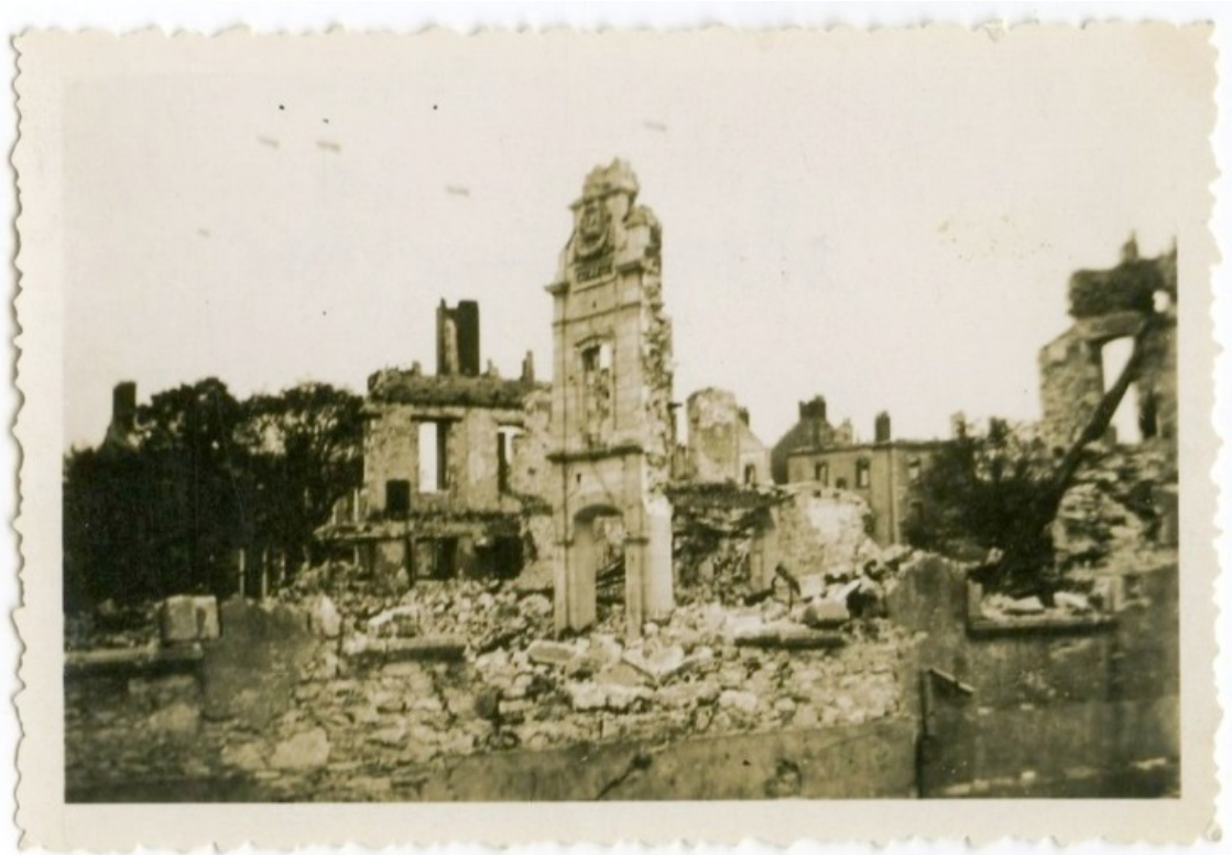
Ruines du Collège de jeunes filles rue Villès-Martin Collection Frenay-Glondou, 5Fi2/26, Archives municipales de Saint-Nazaire
